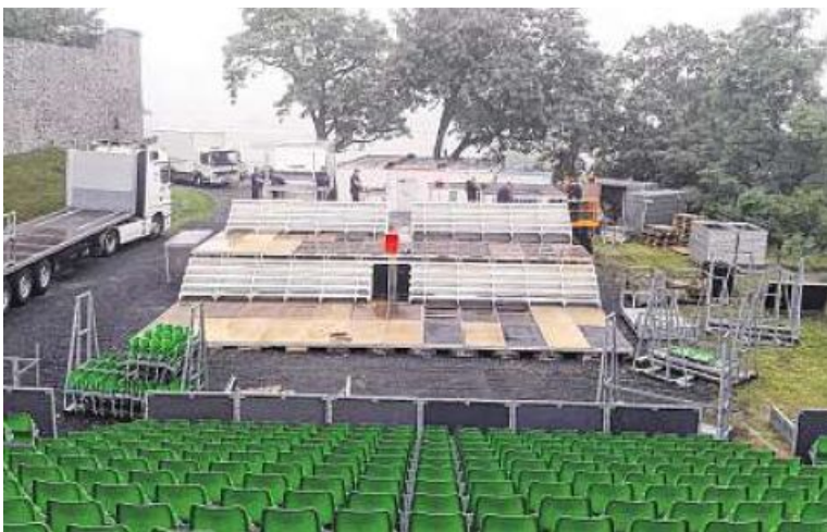
Die Bühne für die Aufführung des Musical-Klassikers „My Fair Lady“ in Bad Kissingen wird derzeit probenhalber in Amöneburg installiert.
